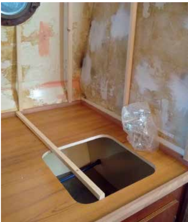
Opbouw en binnenkant stuurhut schuren, plamuren, gronden en lakken, zodat de ramen erin kunnen en de stuurtent klaar is voor de nieuwe kisten, vloer en Morsehendel.
