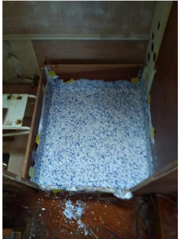
foto 3, aanbrengen glasweefsel en epoxyhars
